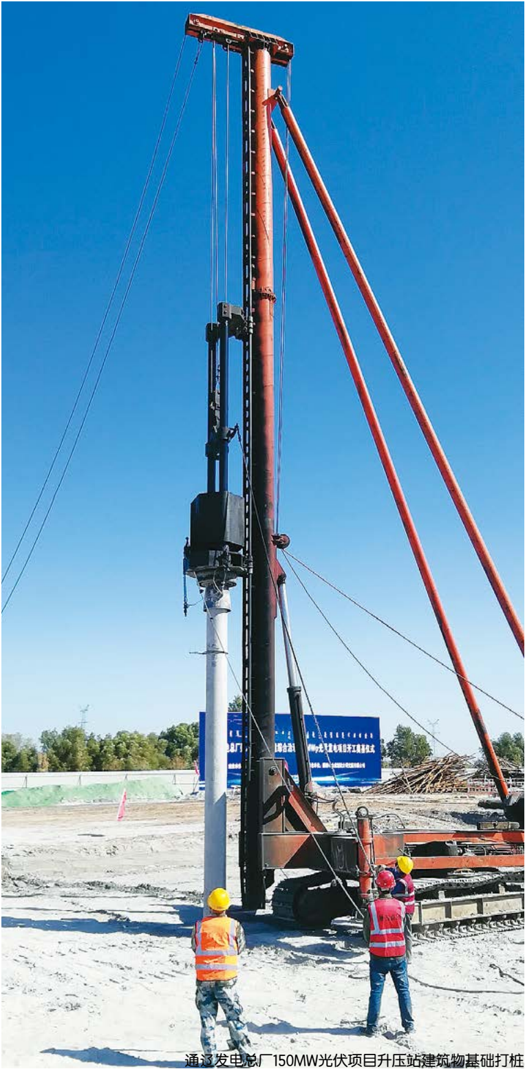
通辽发电总厂150MW光伏项目升压站建筑物基础打桩
