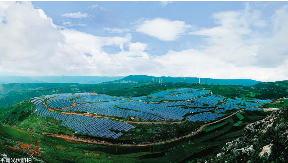
平箐光伏航拍
