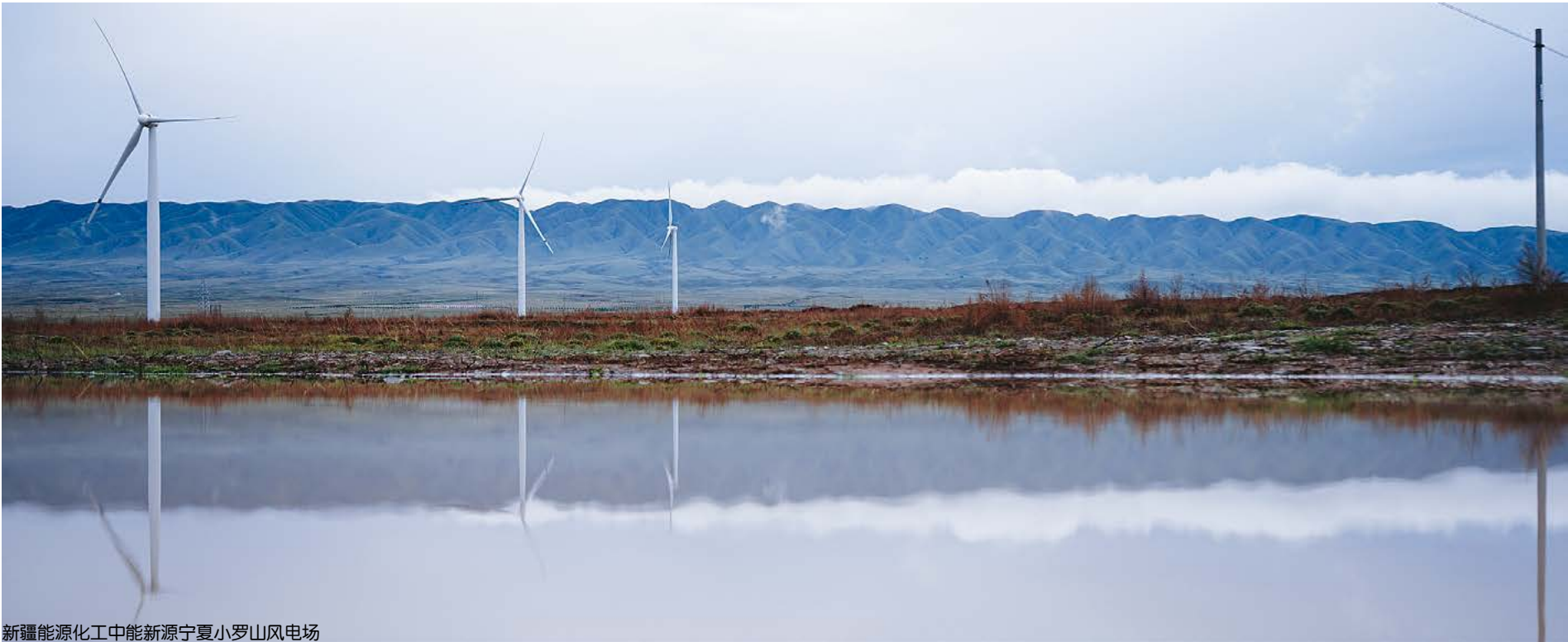
新疆能源化工中能新源宁夏小罗山风电场
