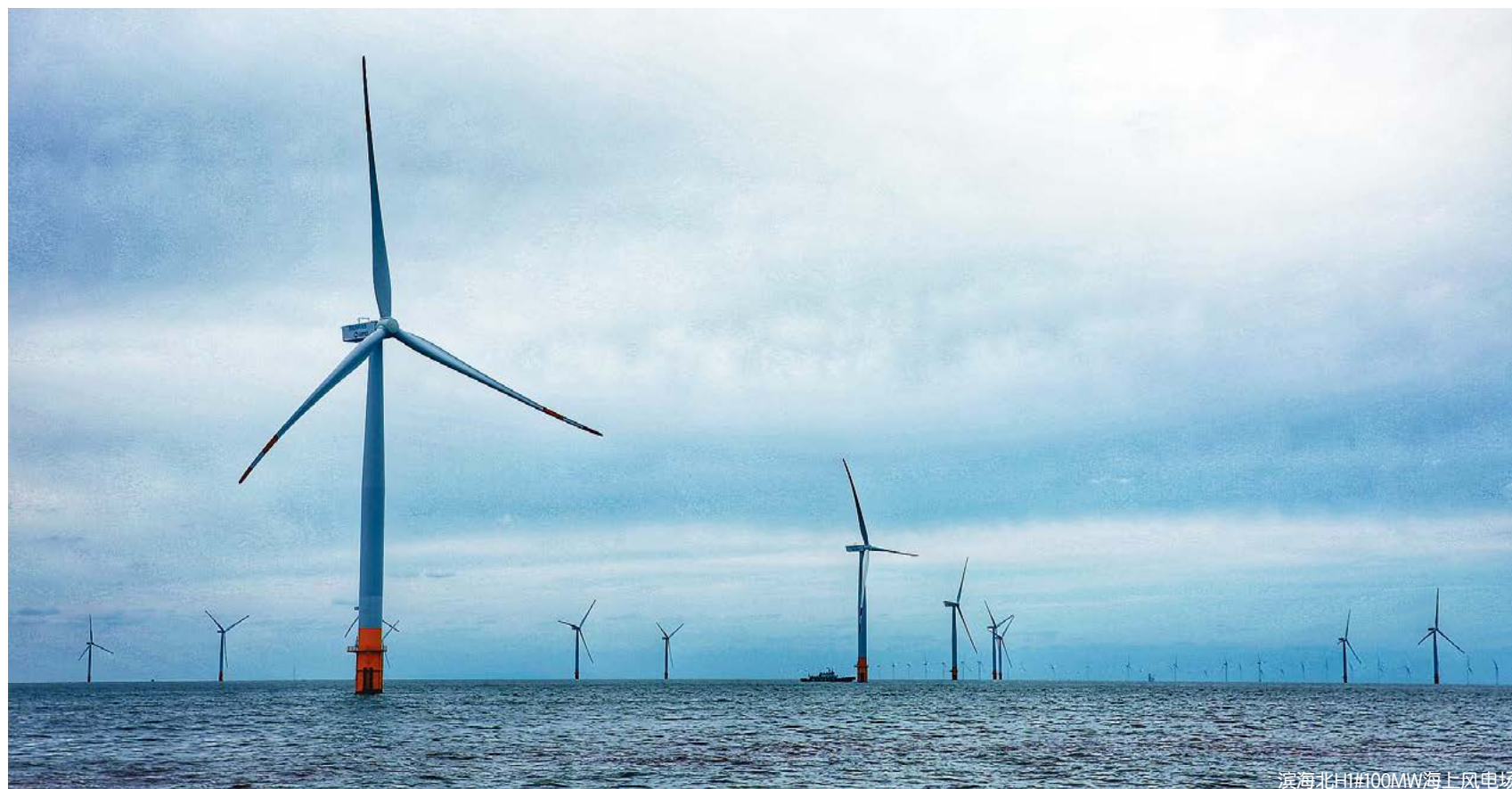
滨海北H1#100MW海上风电场
